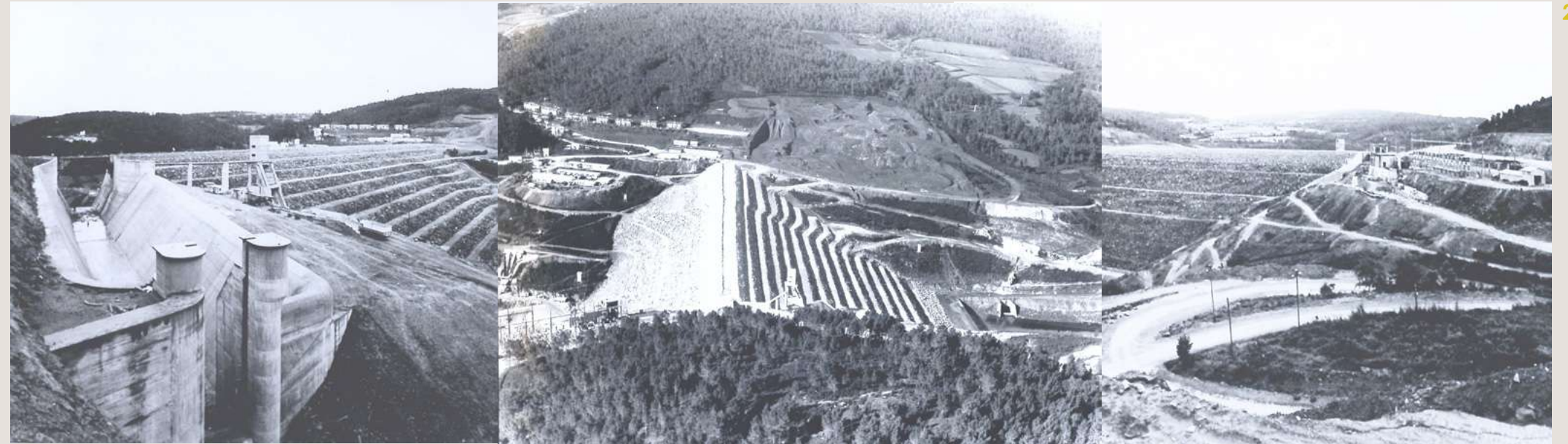
29. Fotografías de central hidroeléctrica.
