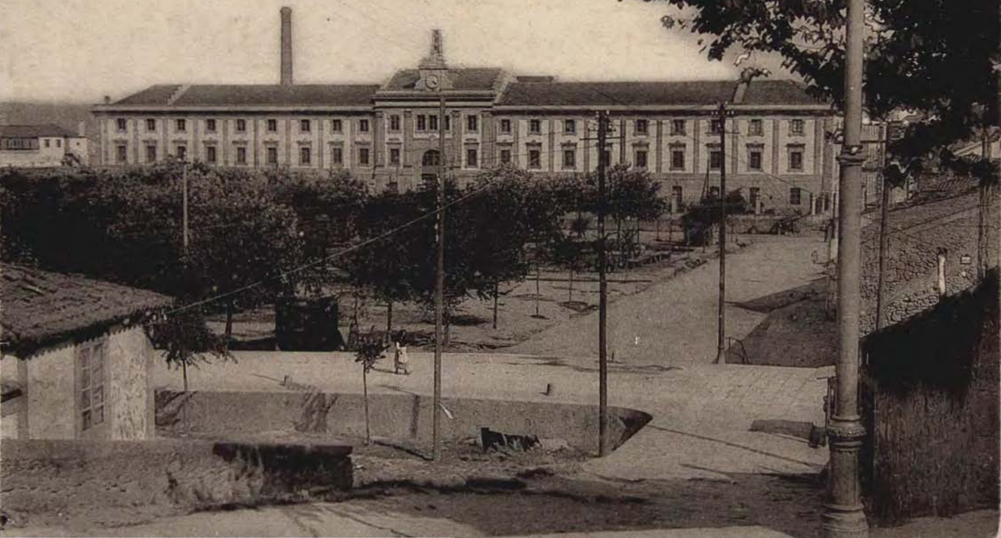
Librería de Lino Perez.-La Coruña, Real 43 10 LA CORUÑA: Fábrica de Tabacos
