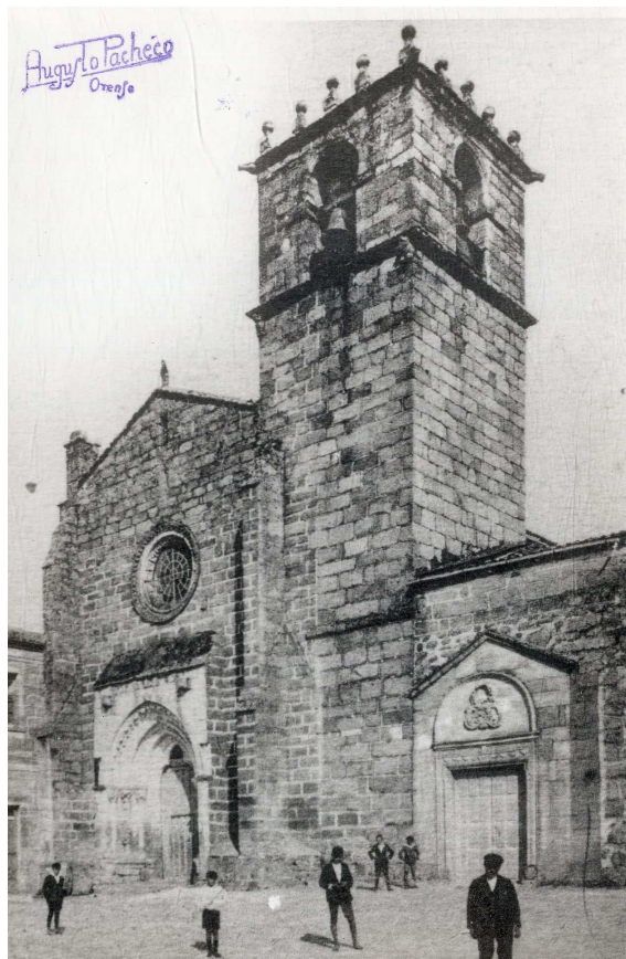
Fachadas de la iglesia gótica de San Francisco y de la capilla de la Orden Tercera en su emplazamiento original en las faldas de Montealegre. AHPOu, Colección fotográfica.
